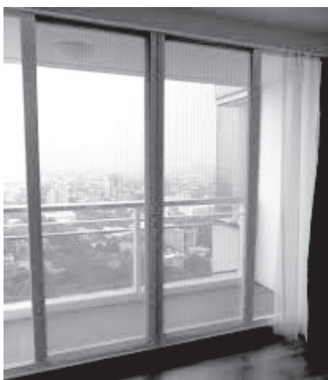
ภาพที่ 10.5 การติดมุ้งลวดที่ประตูทางเข้าบ้านเพื่อป้องกันบุคคลในบ้านจากการถูกยุงกัด ที่มา : สำนักโรคติดต่อฯ โดยแมลง
